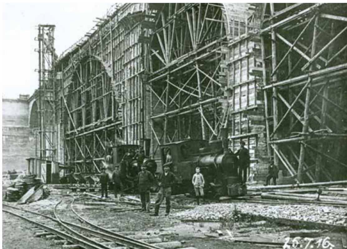
Constructie van het spoorwegviaduct in Remersdael
