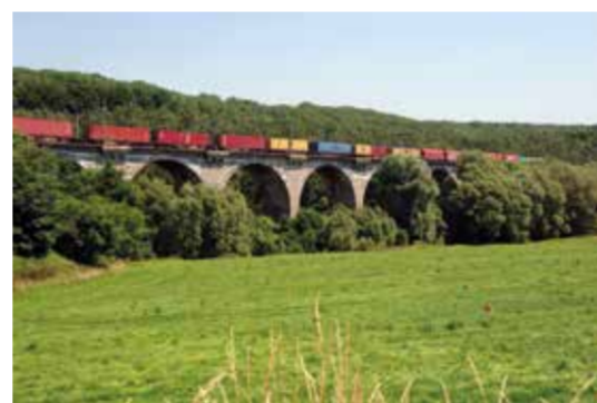
Het spoorwegviaduct in Remersdael
